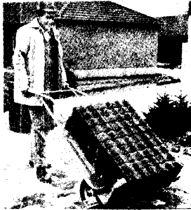
شکل ۹ . حمل بلوک با فرغون مخصوص
