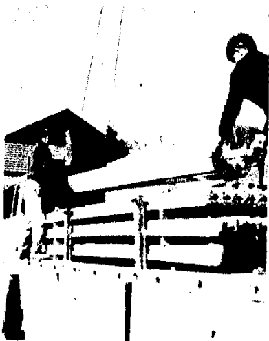
شکل ۱۳. نحوه حمل تیرچه‌ها با جرثقیل و چیدن آنها در کامیون
