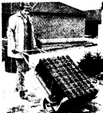
شکل ۹ . حمل بلوک با فرغون مخصوص
